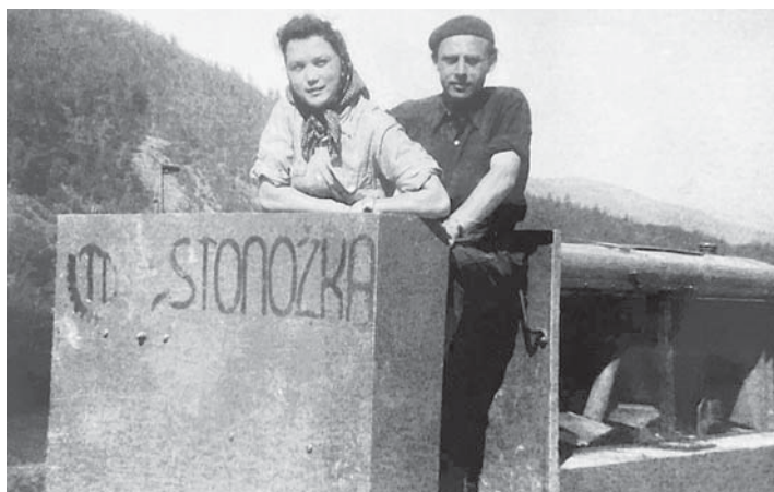
Voľné chvíle počas výstavby Bujanovského tunela.
